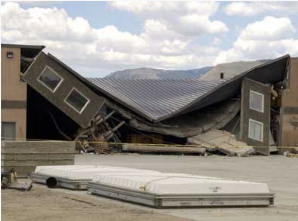
Цементный завод Mountain Park Inc.
